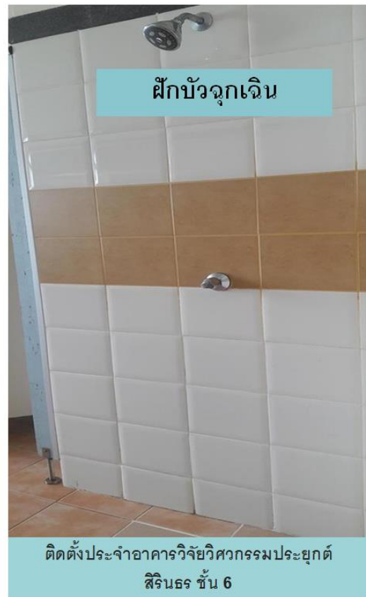
รูปที่ 6 ฝักบัวฉุกเฉินติดตั้งประจำห้องปฏิบัติการภาควิชาวิศวกรรมเคมีและอาคารวิจัยวิศวกรรมประยุกต์ สิรินคร ชั้น 6
