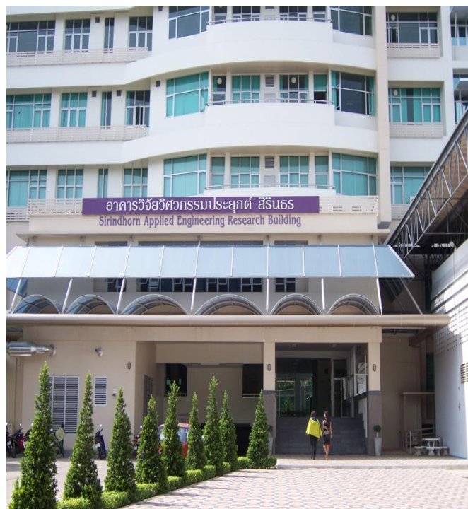
รูปที่ 2 อาคารปฏิบัติการในอาคารวิจัยวิศวกรรมประยุกต์ สิรินคร
